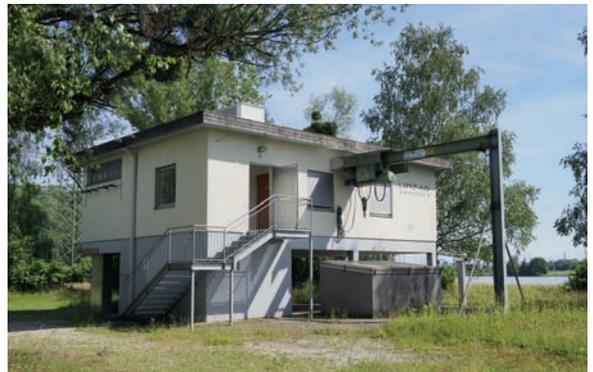
Bei trockenem Wetter transportiert der Düker bis zu 350 l Abwasser pro Sekunde. Die 40 cm dicken Leitungen müssen wöchentlich gespült werden, damit sie nicht verstopfen. Neben den Abwässern führt der Düker auch Trinkwasser vom Wasserwerk Heilham ins Hafengebiet von Linz.
