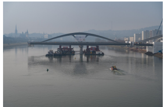
Neue Eisenbahnbrücke Linz – © Isiwal, Wikimedia (CC BY-SA 4.0)
