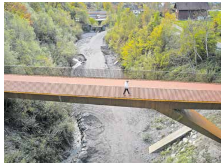
MONTIERT. Auf das Tragwerk wurde ein 121 cm hohes Brückengeländer montiert.
