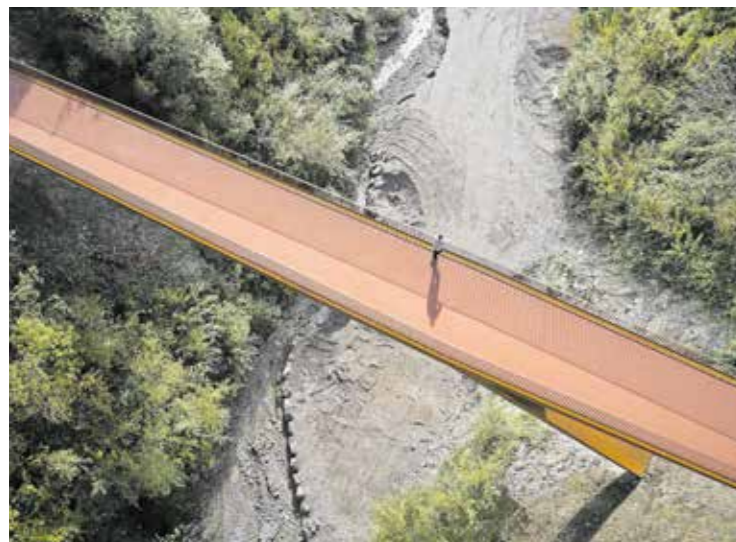
TRAGWERK. Das ungleichschenkelige Tragwerk hat sich durch die Zugänglichkeit zu den Hangflanken entwickelt.
