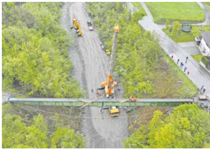
Beindruckende Baustelle, die vorgefertigten Elemente wurden vor Ort montiert.
