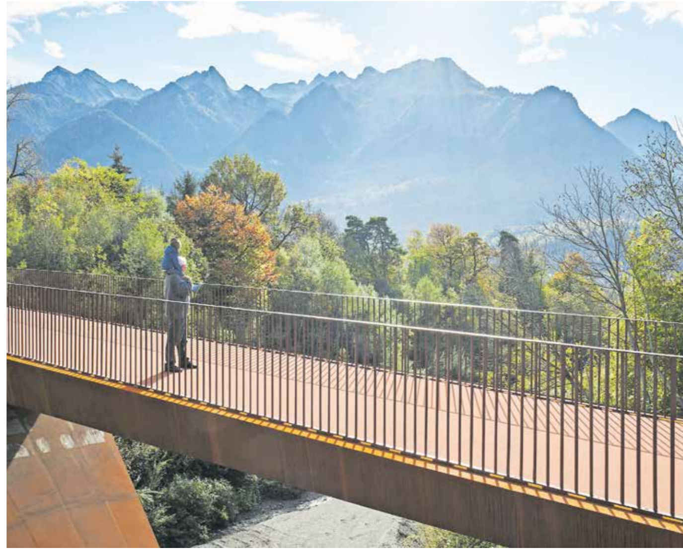
Die Brücke ist nicht nur Infrastruktur, sondern hat auch hohe Aufenthaltsqualität.
