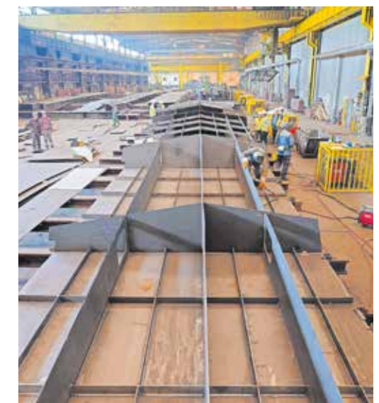
Ein Blick hinter die Kulissen in die Werkstatt. Das gesamte Tragwerk wurde aus wetterfestem Stahl errichtet. Tragwerk und Stütze sind als luftdichter Stahlhohlkasten mit Ober- und Untergurtdeckblech, Längsschotten, Querschotten und örtlichen Aussteifungsstegen ausgeführt.
