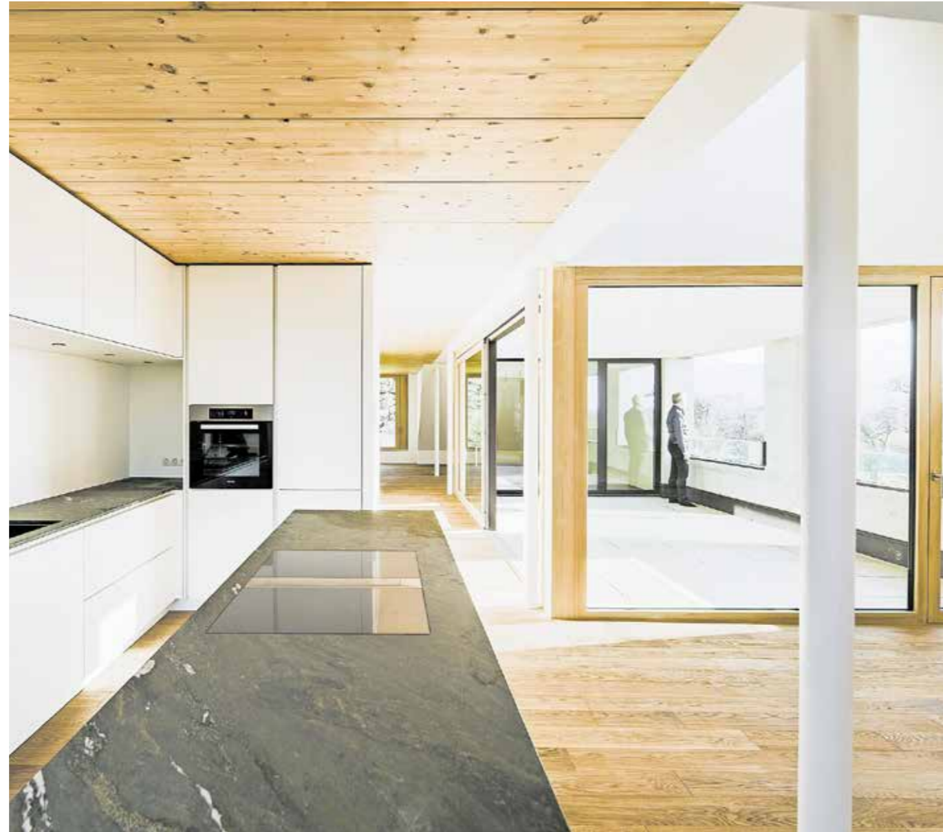
Die Dachwohnungen sitzen als Holzleichtbauten thermisch getrennt zwischen den Betonscheiben.
