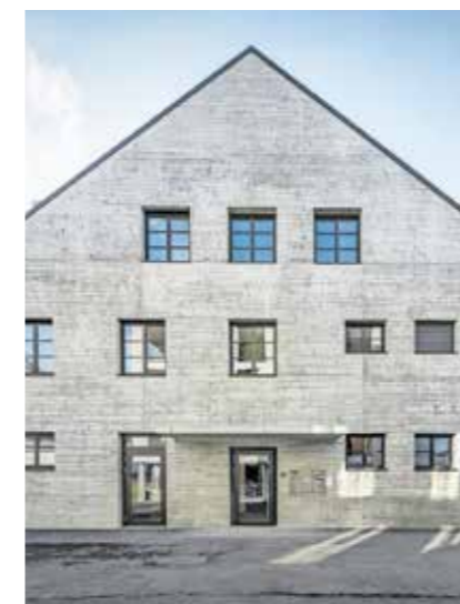
ROBUSTE STRUKTUR Die bestehende Fabrik eignete sich gut für eine Wohnnutzung.
